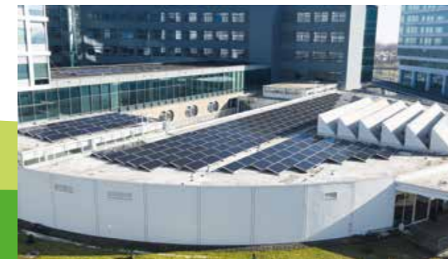
De gemeente verduurzaamt ook haar eigen vastgoed. Zo worden steeds meer daken voorzien van zonnepanelen zoals hier het dak van het stadhuis.
